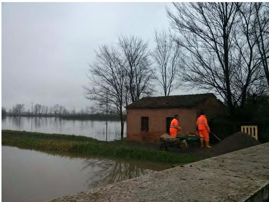
Fig. 36 – operazioni di soprizzo argine sinistro del Dugale Terrazzo per evitare sormonto arginale
